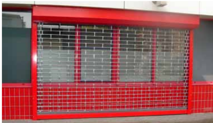
De afdeling radiologie van het IJsselland Ziekenhuis is beveiligd met een rolhek waarvan de omkasting en geleiders gemoffeld zijn in de kleur van de kozijnen.
