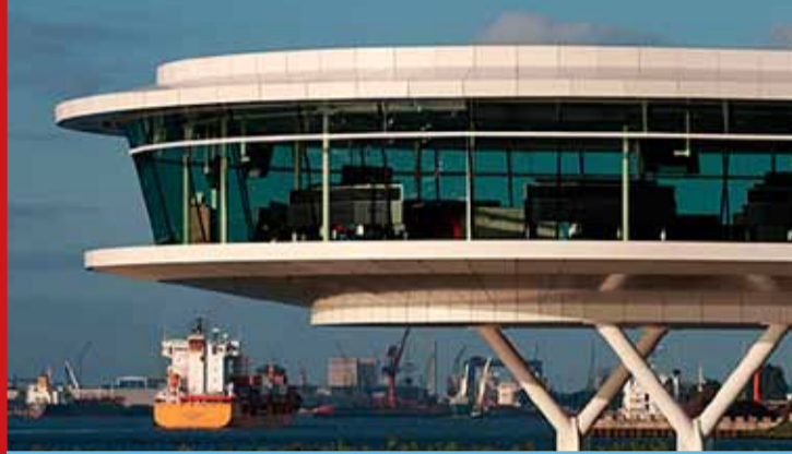
De armaturen zijn strak in de gevel aan de binnenzijde gemonteerd, waardoor de fraaie architectuur van de Verkeerscentrale Rotterdam onveranderd blijft.
