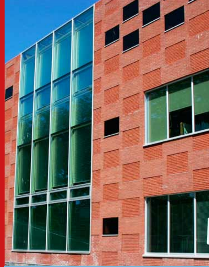
De Max Line rolgordijnen van Multifilm zorgen voor een goede warmtewering in de diverse ruimtes van LOC+ Hardenberg.
