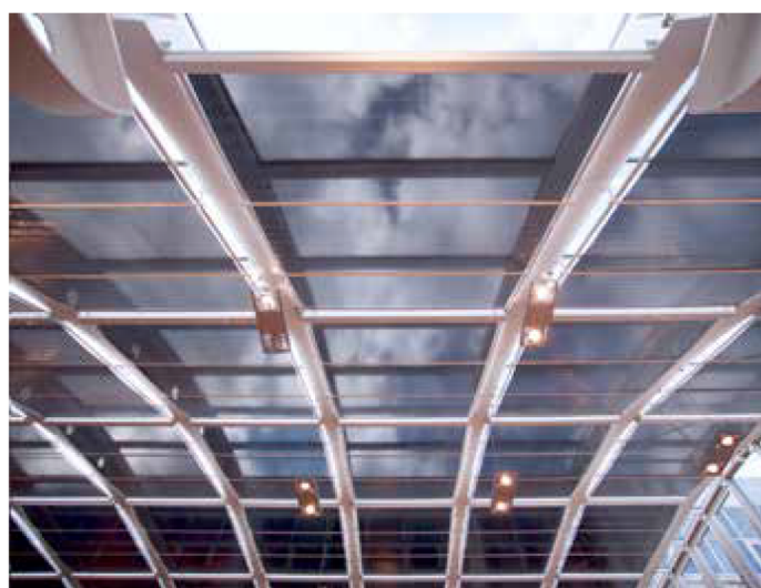
De horizontale systemen voor de glasdaken zijn volledig nieuw ontwikkeld met onzichtbare techniek, weggewerkt in het spant.
